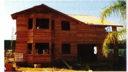
Vista de frente já quase concluída
