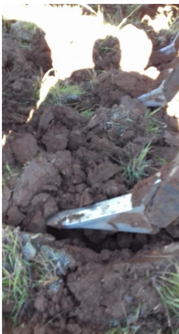
Figura 11. Descompactação do solo
