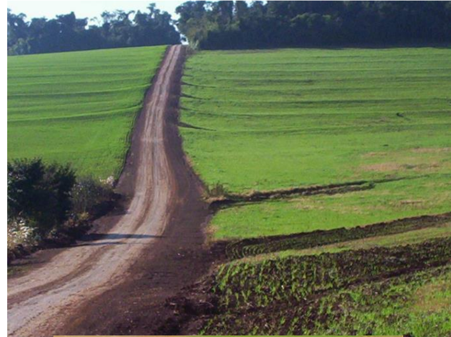
Lavoura recebendo a água da estrada
